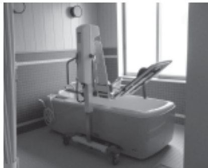
新設される地域密着型介護老人福祉施設（特別浴室）
