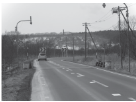
道道大津旅来線大津小橋付近
