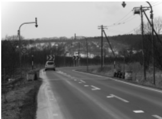
道道大津旅来線大津小橋付近
