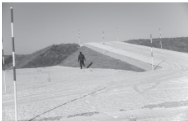
大津地区に整備中の築山
