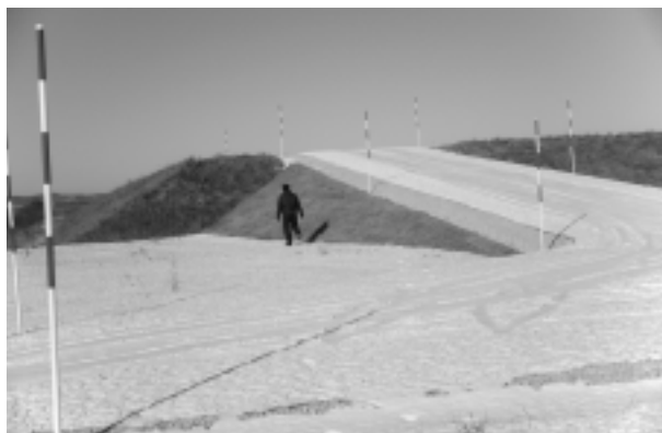
大津地区に整備中の築山
