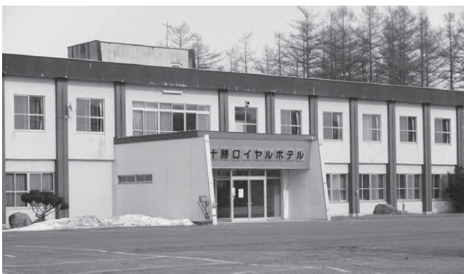
老朽化している十勝ロイヤルホテル
