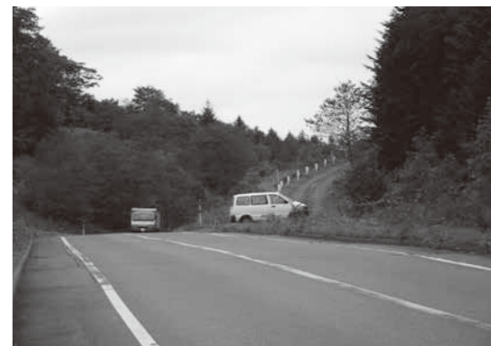
国道336号避難場所予定地
