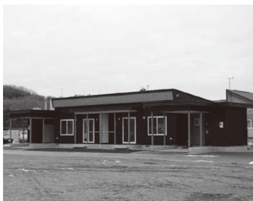
町営住宅外観
