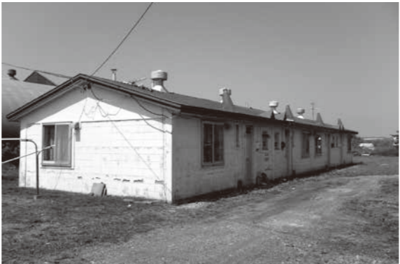
S46年建築の公営住宅
