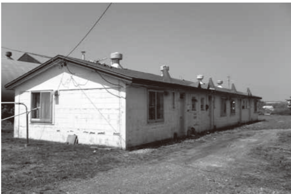
S46年建築の公営住宅
