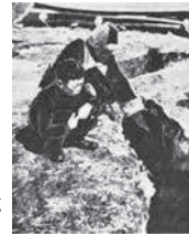
△昭和27年の十勝沖地震によってできた大津海岸の亀裂
