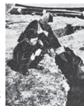
△昭和 27 年の十勝沖地震によってできた大津海岸の亀裂
