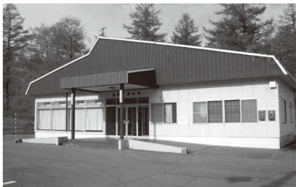
築35年経過の葬斎場
