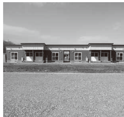
茂岩岩町に建設された高齢者住宅
