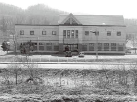
茂岩下水浄化センター
