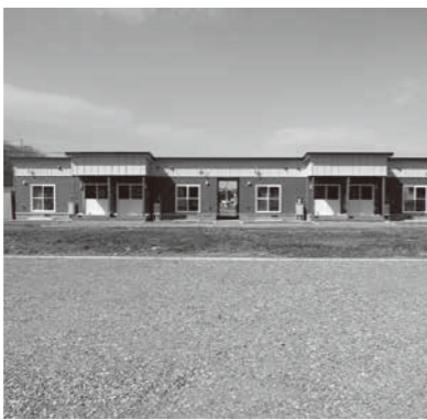
茂岩岩町に建設された高齢者住宅
