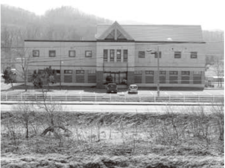
茂岩下水浄化センター
