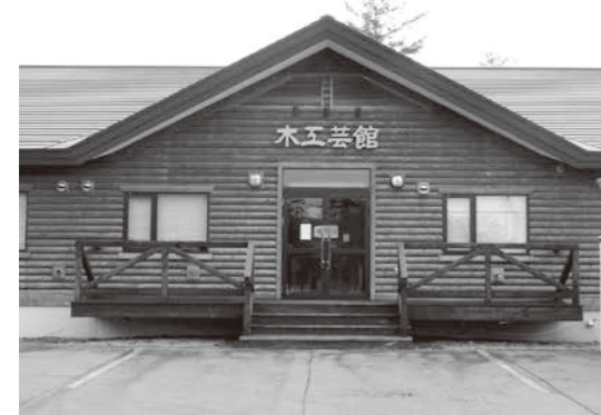
今後の利用が検討される木工芸館
