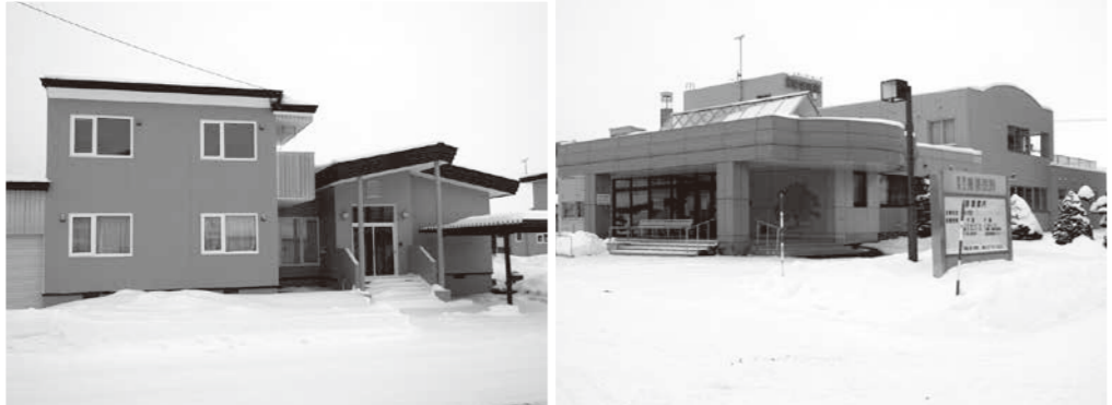
改修する豊頃医院と院長住宅
