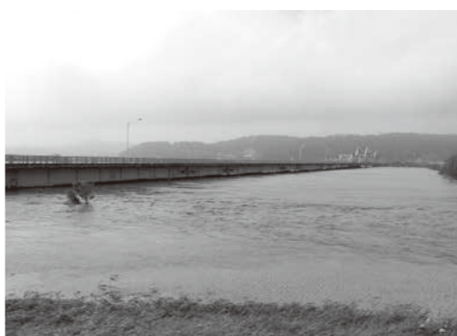
大雨により増水した十勝川
