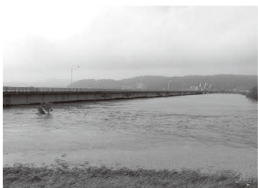
大雨により増水した十勝川
