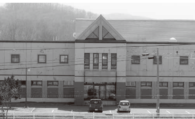
茂岩下水浄化センター
