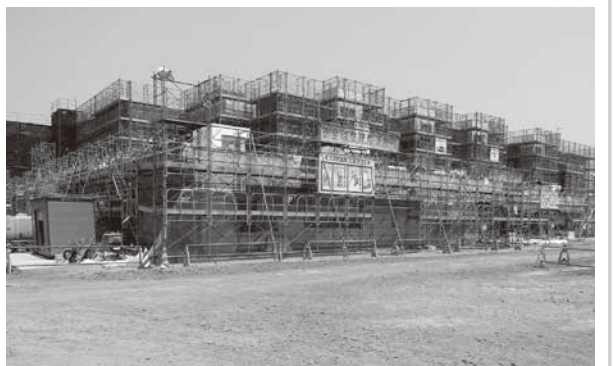
白糠町で建設中の義務教育学校
