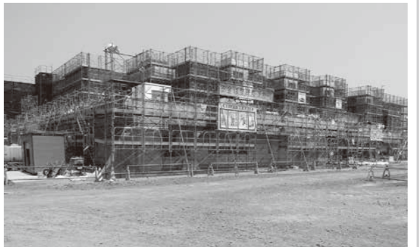
白糠町で建設中の義務教育学校
