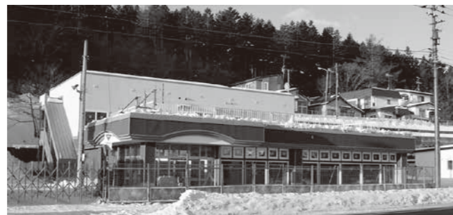
写真左／現在工事中の拠点施設
