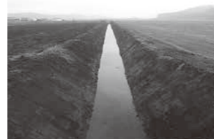
＜整備後の西原幹線排水路
