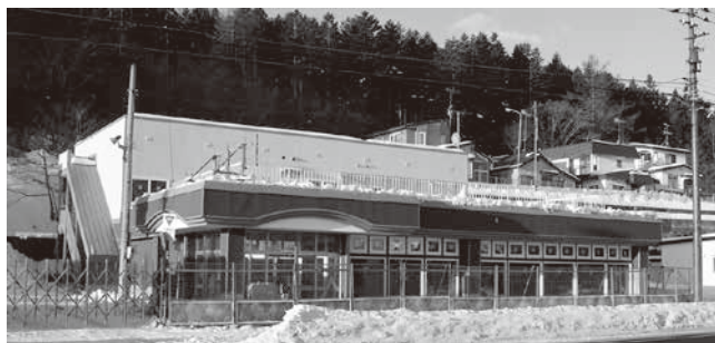
写真左／現在工事中の拠点施設
