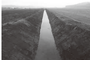
◁整備後の西原幹線排水路
