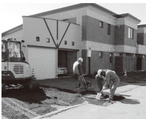
土木工事の様子
