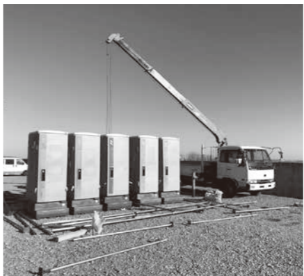
ジュエリーアイス観光客への仮設トイレ
