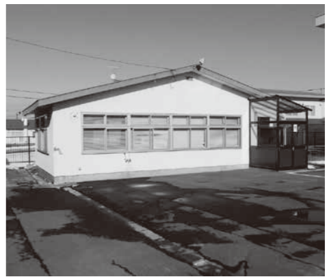
改修を行う福祉センター近くの物置
