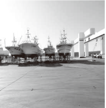
現地視察した大津漁港船揚場と漁船上架施設
