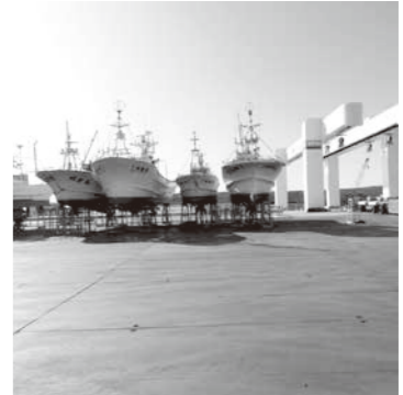
現地視察した大津漁港船揚場と漁船上架施設
