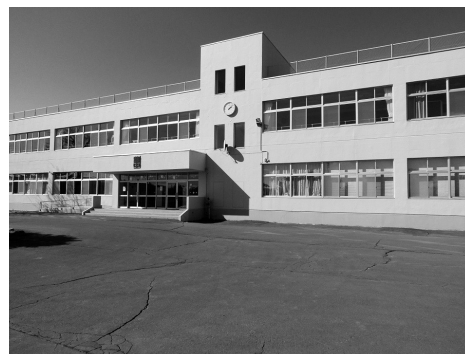
改築を予定されている豊頃中学校
