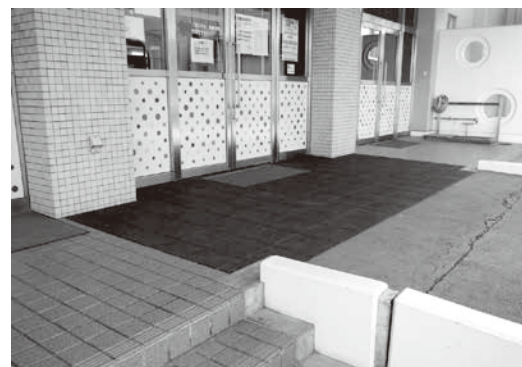
昨年度施工された正面玄関入口中央部の滑り止め
