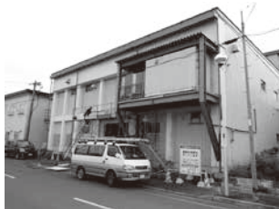
産業活性化施設 1階部分（東1条通り）
