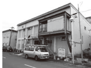
産業活性化施設 1階部分（東1条通り）
