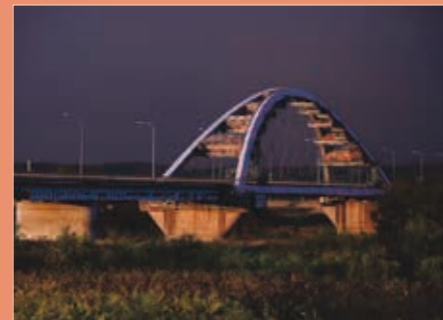
【特選一席】豊頃町観光協会会長賞 高木 皓「大橋の上部補強工事」
