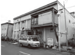
産業活性化施設 1階部分（東1条通り）
