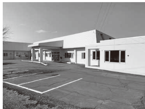
大規模改修工事が行われるとよころ荘
