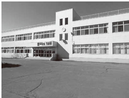
建替えが検討される豊頃中学校校舎
