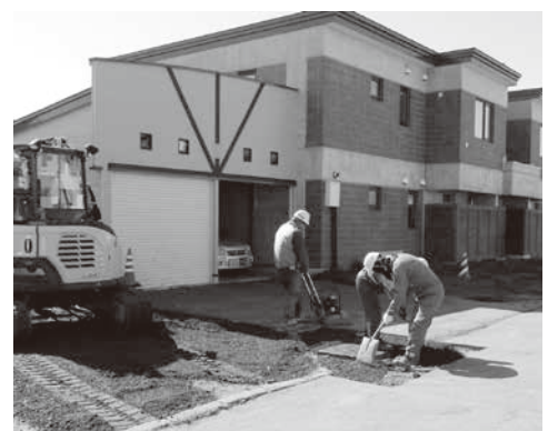
土木工事の様子
