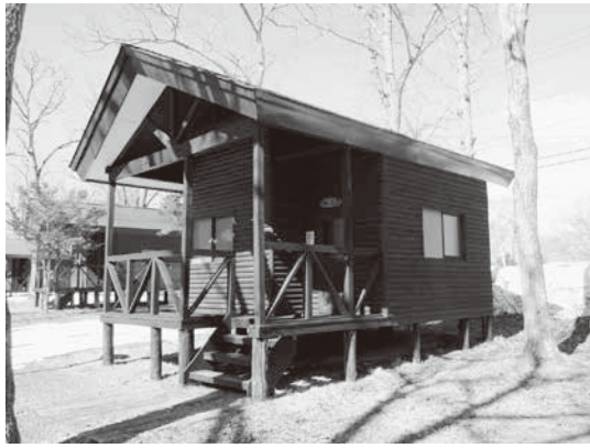
改修する茂岩山自然公園のバンガロー
