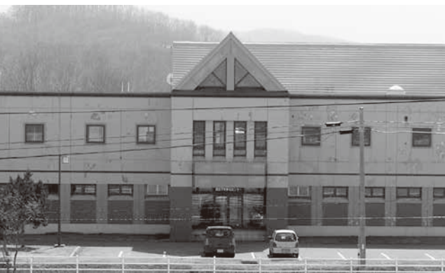
茂岩下水浄化センター
