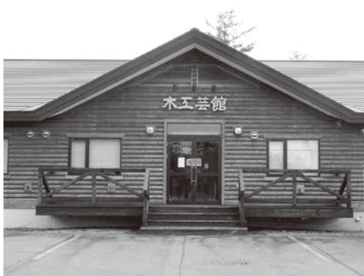
今後の利用が検討される木工芸館
