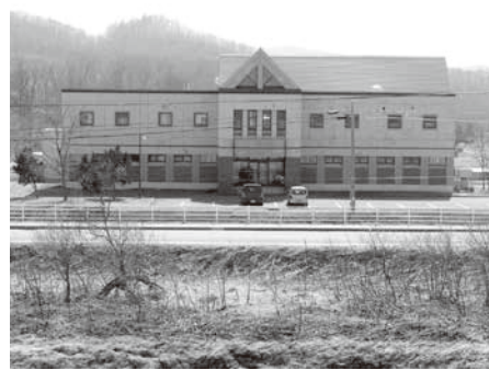
茂岩下水浄化センター
