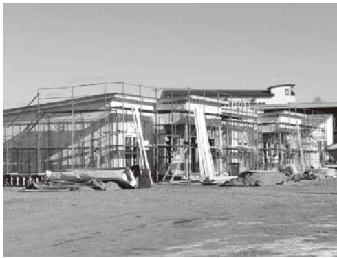
茂岩栄町に建設中の「地域優良賃貸住宅（高齢者住宅）」
