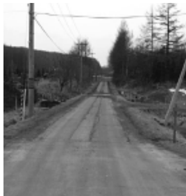
改良舗装中の二宮第1号支線
