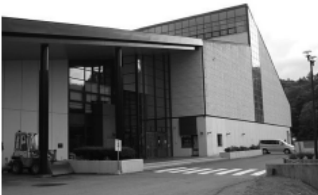
町総合体育館
