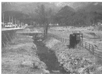
大谷川を水源とする日光五カ村用水
