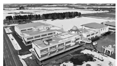
豊頃小学校・豊頃中学校併設校舎 外観
