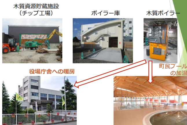
知内町 木質チップボイラー（知内町資料より）
