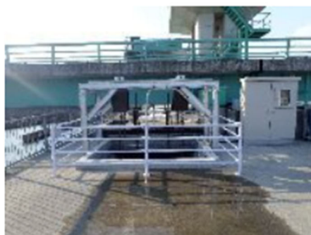
沼の沢取水堰発電所
