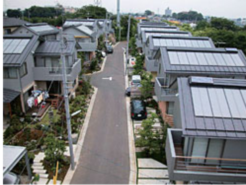
ソーラータウン久米川（資源エネルギー庁 HP より）
