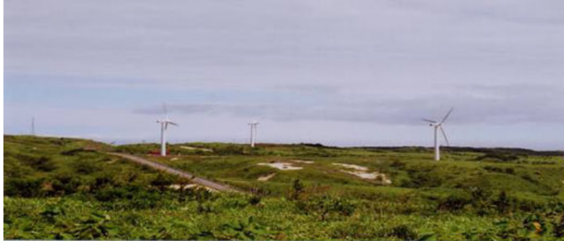
稚内市水道事業風力発電所（稚内市 HP より）
