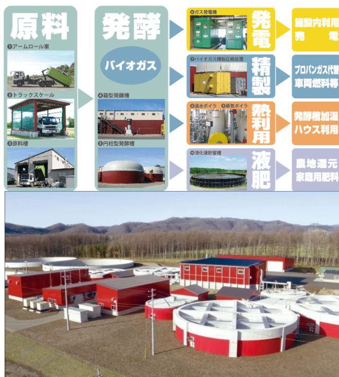
鹿追町環境保全センター瓜幕バイオガスプラント（鹿追町 HP より）
