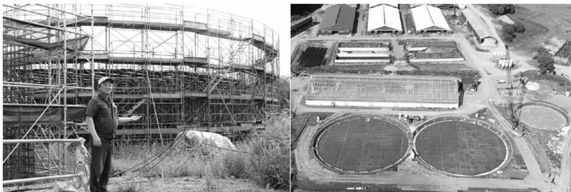
図 1 町内に建設中のバイオガスプラント（2025（令和 7）年完成予定）
