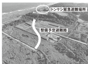
トンケシ高台側避難路の整備予定地（白線部分に避難路を整備する計画です。）
