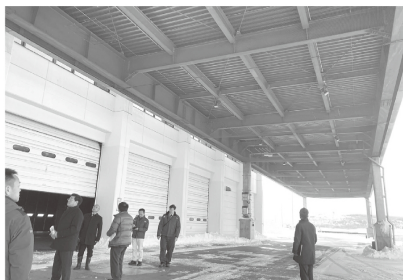
令和6年に完成した岸壁側屋根施設
