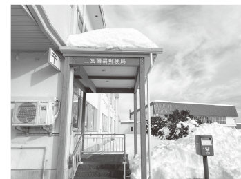
入口階段とアルミのひさし
